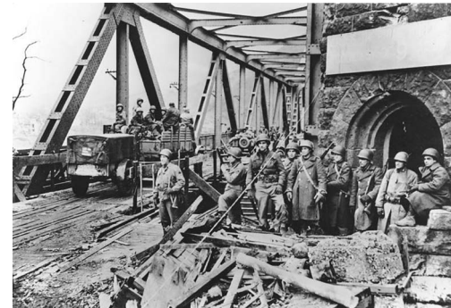
Amerikanische Soldaten auf der beschädigten Brücke von Remagen, zwischen 8. und 10. März 1945. Fotograf: Helmut J. Wolf.
