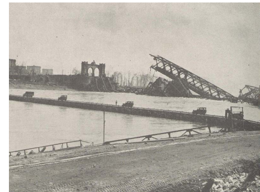
Ende März 1945: Die zerstörte Rheinbrücke zwischen Mannheim und Ludwigshafen. Im Vordergrund Behelfsbrücke der US-Armee.
