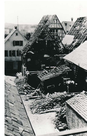
Bombenschäden in der Kirchstraße.
